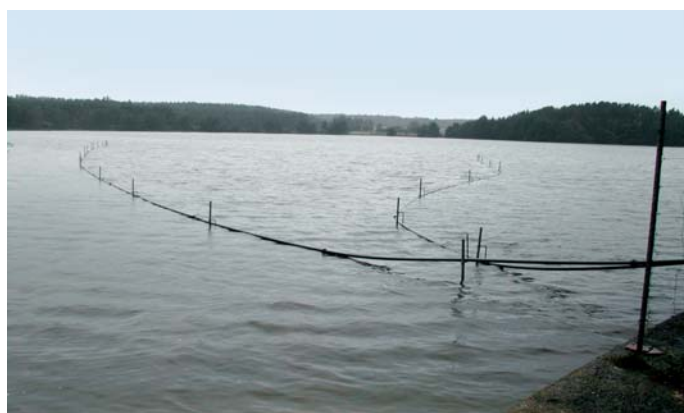
Potrubí na rybníce
